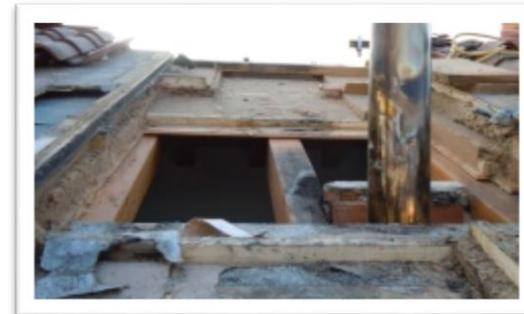
Estradosso ventilato con pannelli non sottoposti a carico
